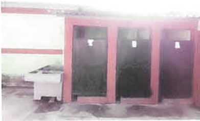
Foto 3. Tuberia de agua arreglada,
