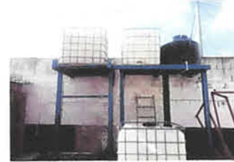
Foto 4. Base para tinacos reparada y mejorada.
